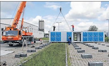
Auf dem Parkplatz des Bauhofes an der Mercatorstraße werden jetzt Wohncontainer für 40 Menschen aufgestellt. Foto: Timo Jann
